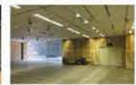
展示室は壁・床を撤去
