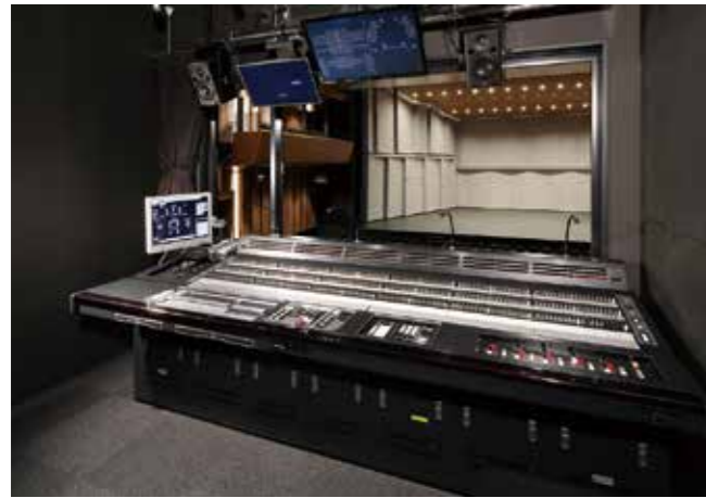
ロームシアター京都 サウスホール (据置型) ROHM Theatre Kyoto South Hall 京都府京都市 Kyoto city, Kyoto pref.
