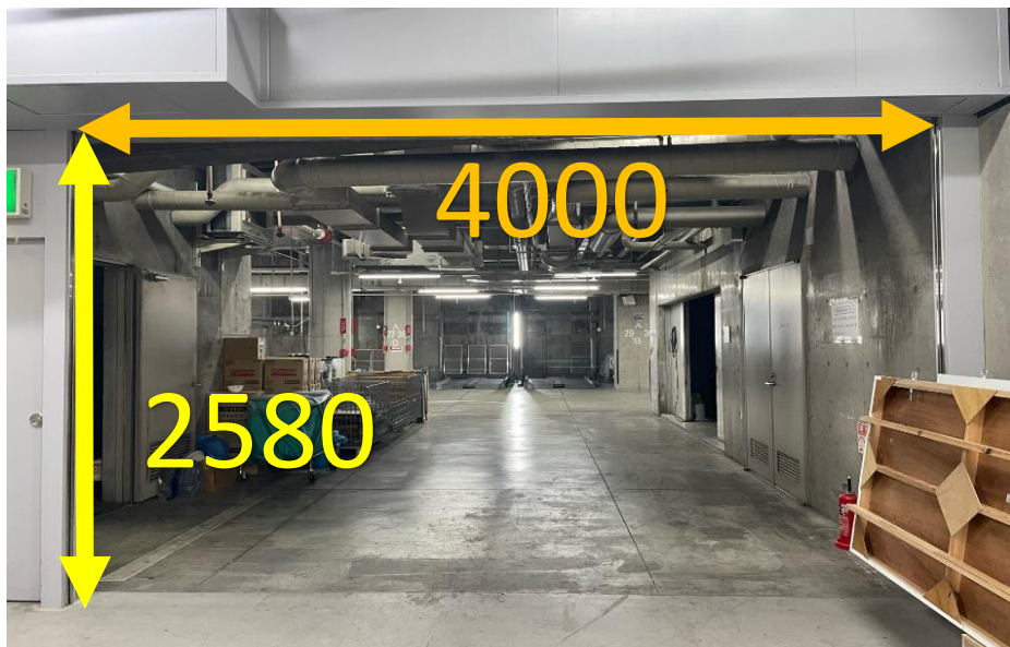
地下2階駐車場舞台上手側への搬入口
