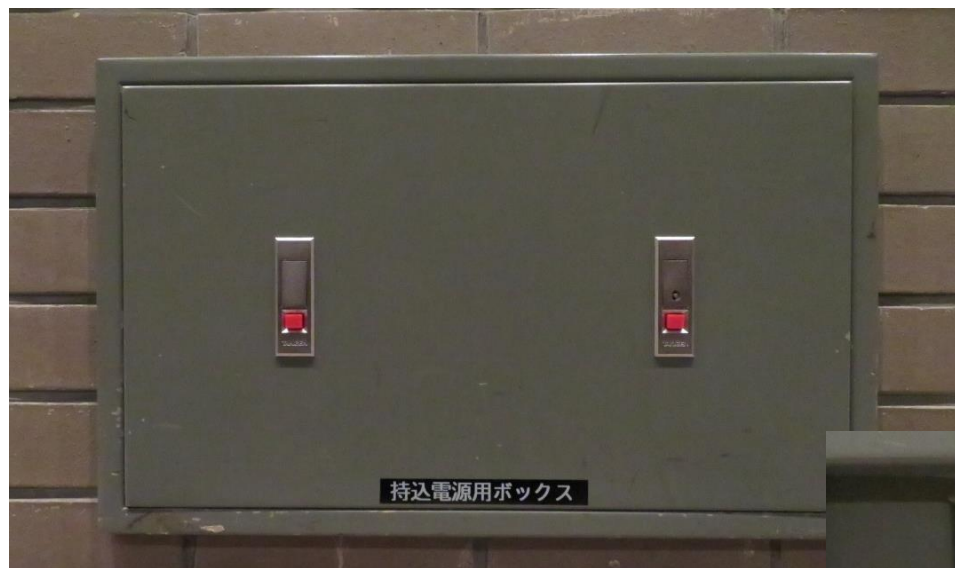
客席最後方壁面 持込DMX・電源ボックス
